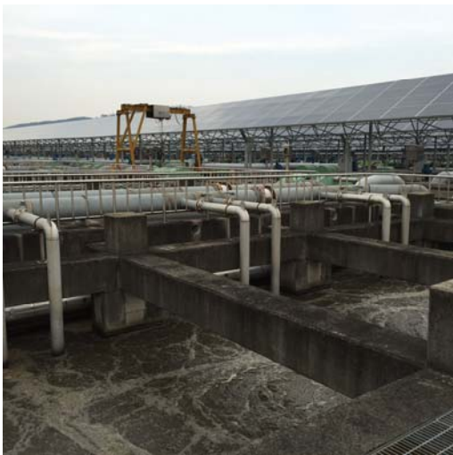
写真 下水処理場、太陽光パネルも
